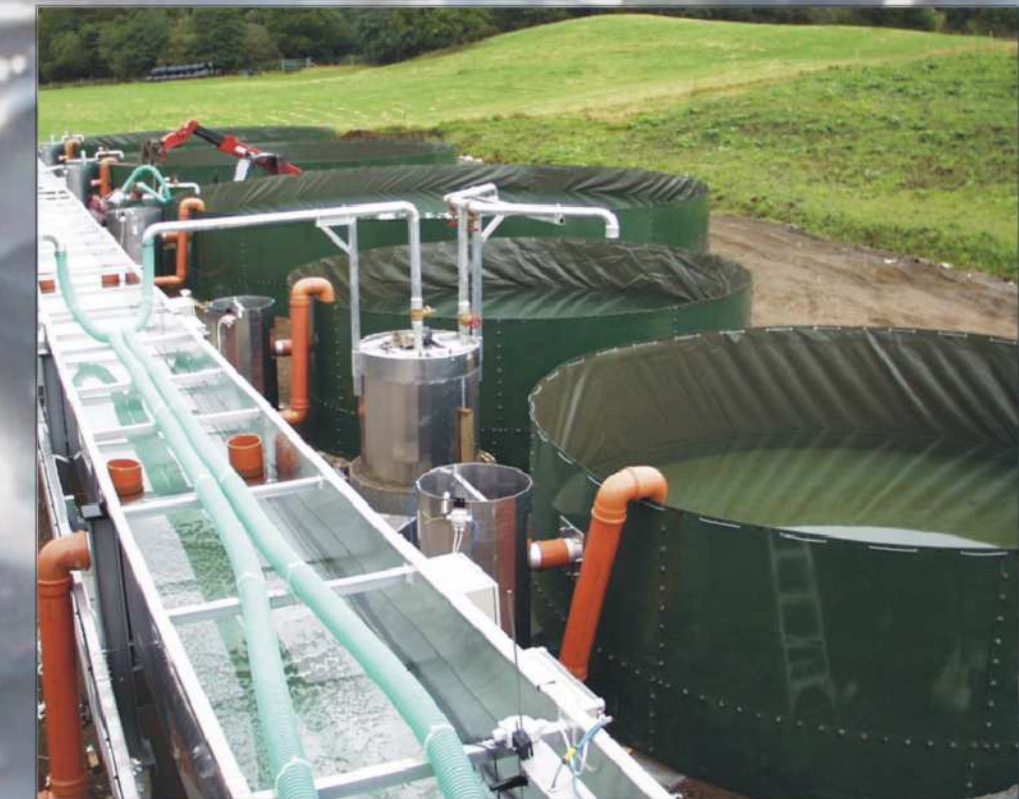
Bild 2: durch den Umbau wurde die Fischfarm auf das derzeit höchste technologische Produktionsniveau gebracht
